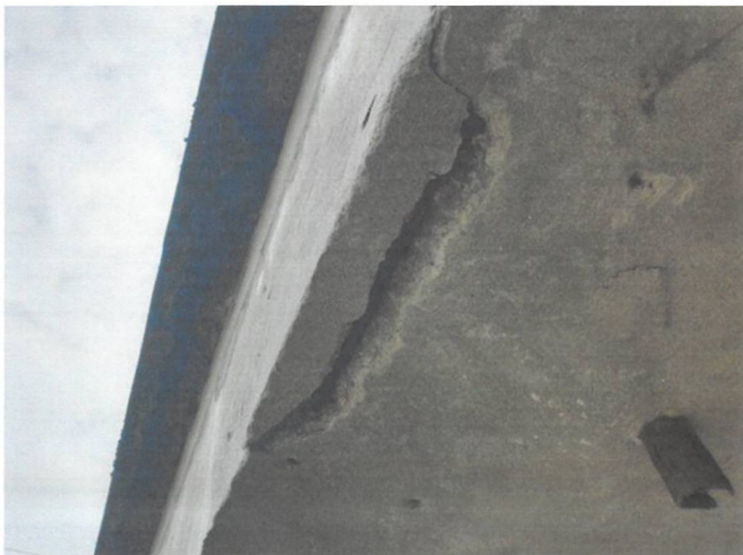
Fot. 26. Widok na płytę pomostu od strony dolnej wody przy przyczółku od strony Sokołowa – odspojenie części betonu powstałe w wyniku pęcznienia korodującego zbrojenia.
