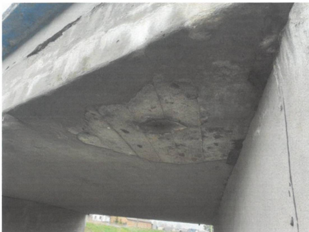
Fot. 23. Widok na płytę pomostu od strony górnej wody przy przyczółku od strony Łańcuta – ubytki materiału warstwy wyrównawczej wokół pozostałości po rurze spustowej sączka powstałe w wyniku przecieków wody.
