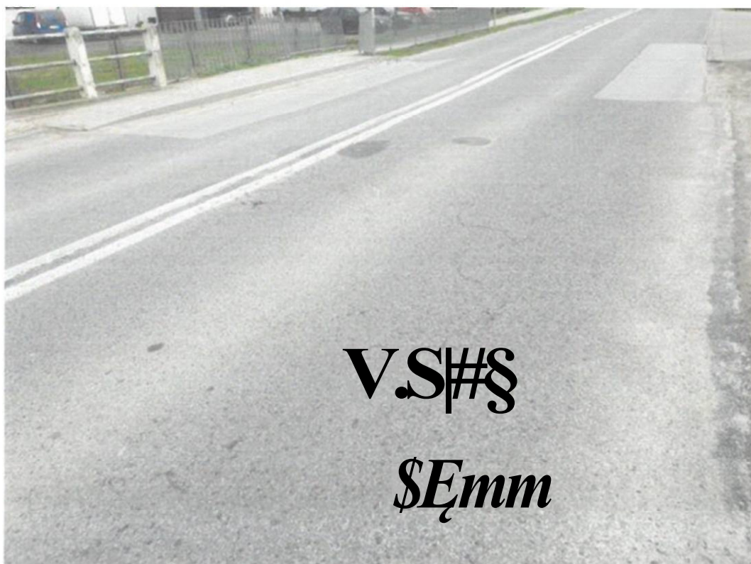
Fot. 38. Widok na dojazd od strony Łańcuta – siatka spękań w osi jezdni oraz na prawym pasie ruchu.
