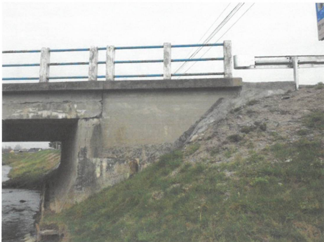
Fot. 36. Widok od strony górnej wody na skrzydelko przyczółka od strony Łańcuta – zacieki powstałe z powodu braku przebiecia dylatacyjnego, zarysowania, niedostateczne obsypanie skrzydelka w górnej części.
