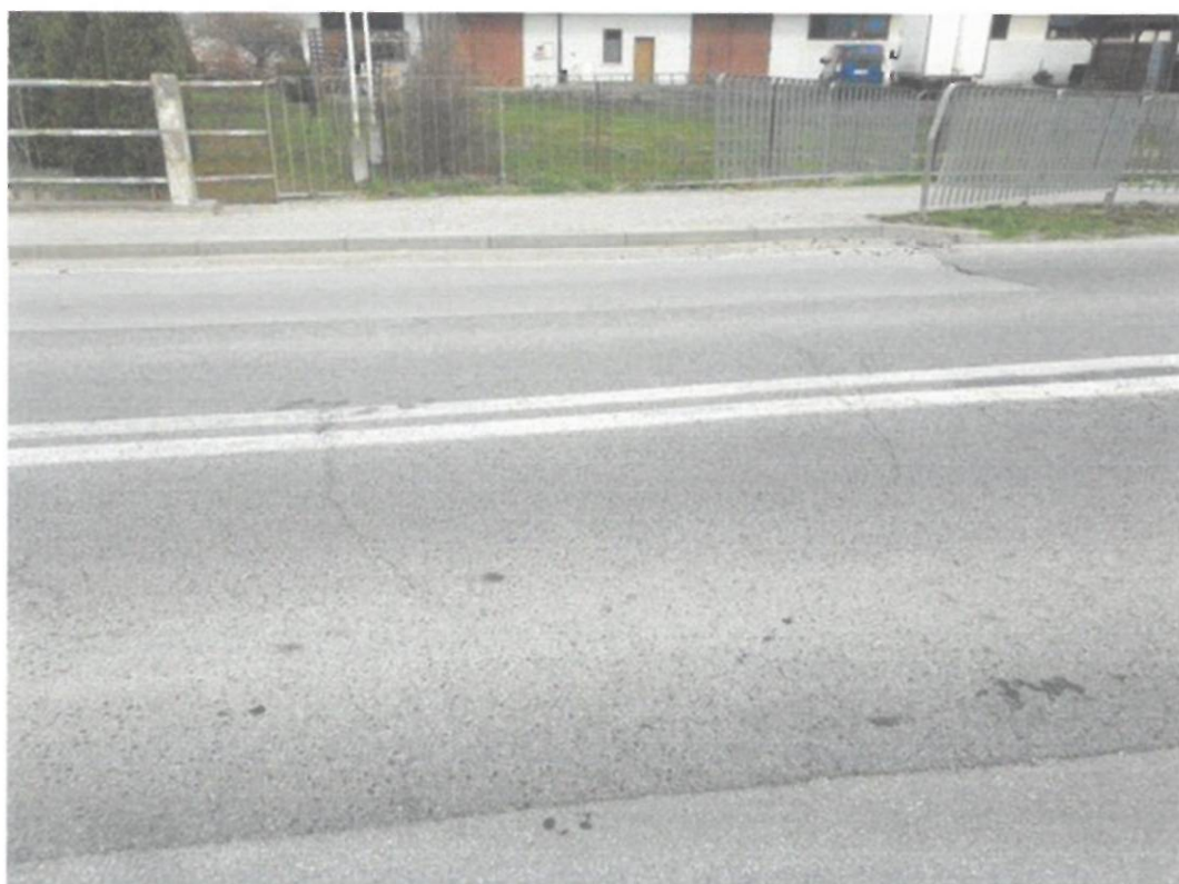
Fot. 40. Widok na dojazd od strony Łańcuta – siatka spękań w osi jezdni.
