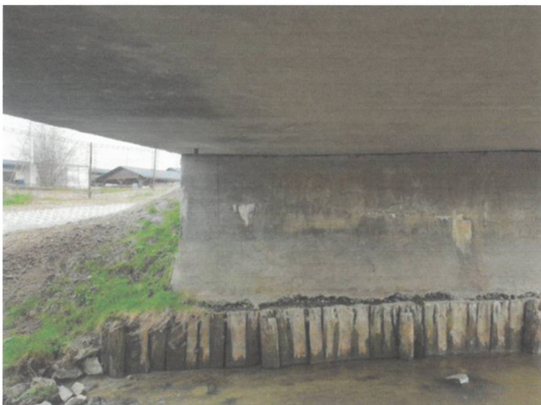
Fot. 32. Widok na przyczółek od strony Łańcuta – białe wykwity wapienne w miejscu poziomej rysy, ubytki betonu w dolnej części korpusu powstałe w wyniku erozji wodnej, zanieczyszczenia w postaci graffiti.
