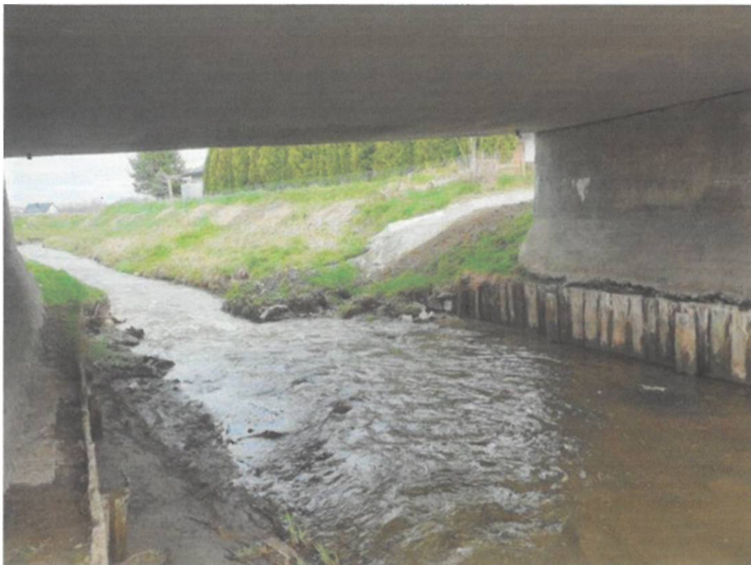
Fot. 21. Widok na dolną powierzchnię płyty pomostu – od strony dolnej wody widoczne zawilgocenie powierzchni pomostu świadczące o nieszczelnej izolacji..
