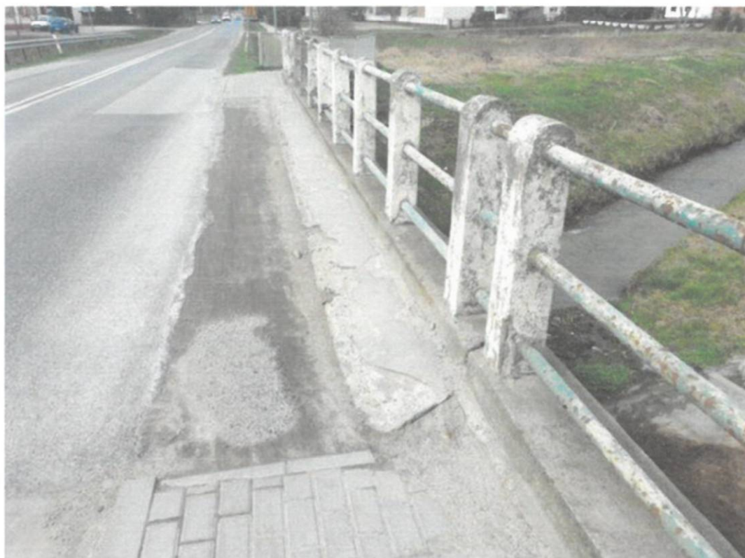
Fot. 9. Widok od strony Łańcuta na chodnik od strony dolnej wody – brak stalowego kątownika kapy chodnikowej, ubytki betonu kapy, zanieczyszczenia na powierzchni pobocza.
