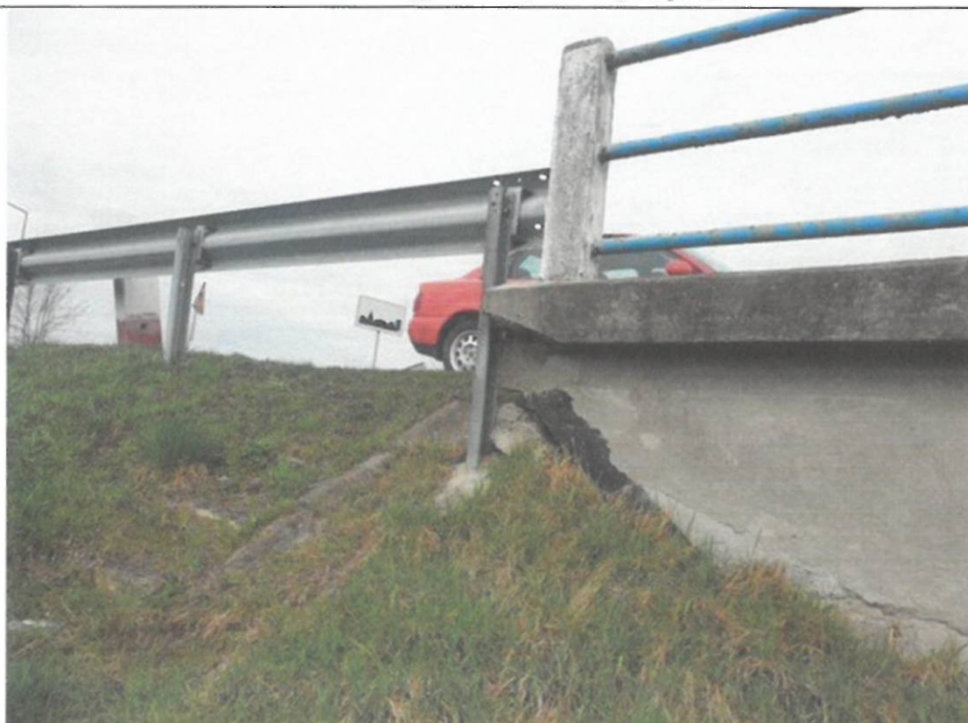
Fot. 30. Widok od strony górnej wody na skrzydelko przyczółka od strony Sokołowa – niedostateczne obsypanie skrzydelka w górnej części.
