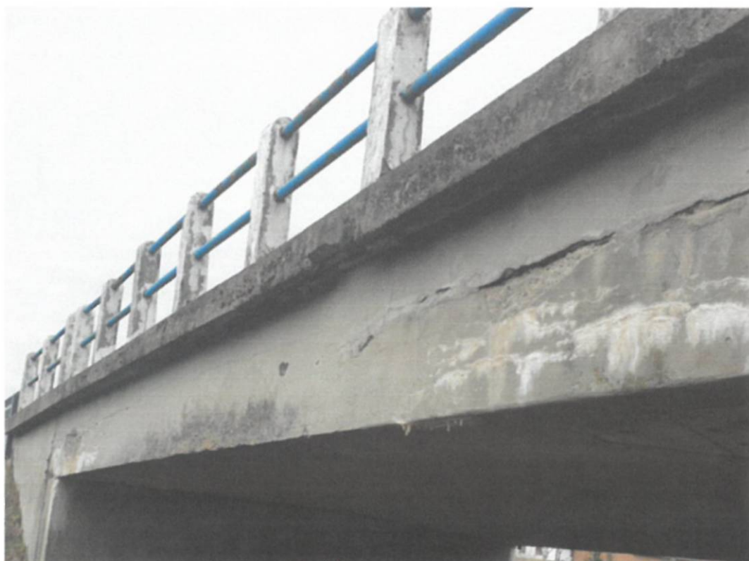
Fot. 10. Widok na gzyms od strony górnej wody – ubytki betonu gzymsu.
