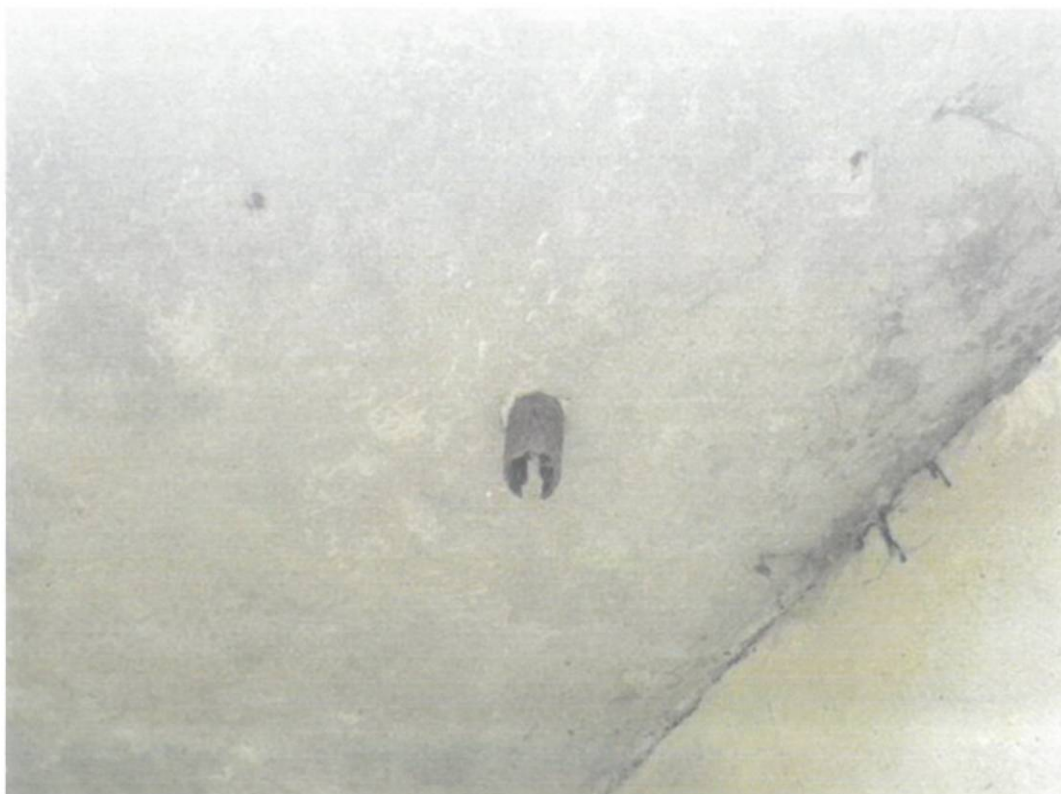
Fot. 14. Widok na rurę spustową sączka w płycie pomostu – całkowicie skorodowana rura spustowa.
