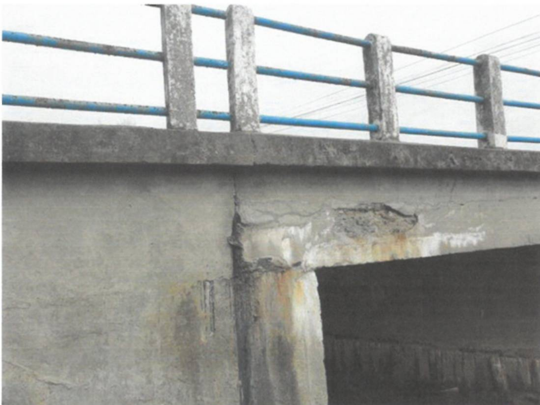
Fot. 22. Widok na boczną powierzchnię płyty pomostu przy przyczółku od strony Sokółowa od górnej wody – białe zacieki, zarysowania i ubytki materiału bocznej powierzchni betonu świadczące o korozji ługującej beton.
