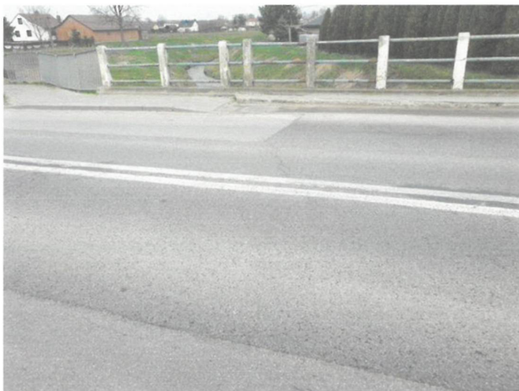
Fot. 15. Widok na nawierzchnię jezdni nad szczeliną dylatacyjną od strony Sokółowa – pęknięcia jezdni na szczelinę.
