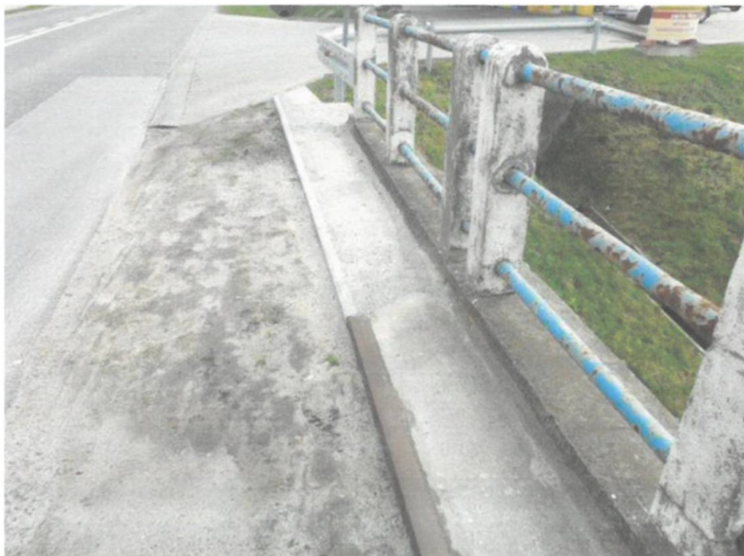
Fot. 8. Widok od strony Sokołowa na chodnik od strony górnej wody przy zejściu z mostu – korozja kątownika kapy chodnikowej, zanieczyszczenia na powierzchni pobocza, nowo wykona część kapy na długości skrzydelka i tuż za nim
