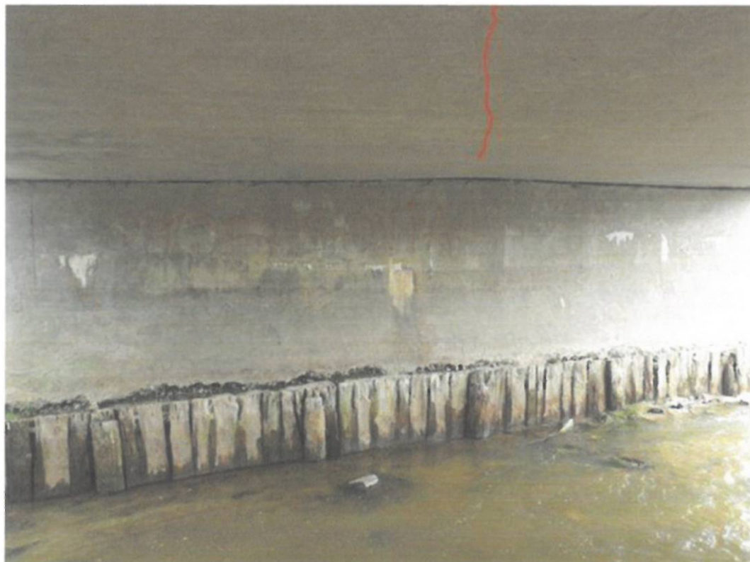
Fot. 18. Widok na dolną powierzchnię płyty pomostu – zarysowanie podłużne płyty pomostu w osi jezdni o rozwarości do 0.7 mm.
