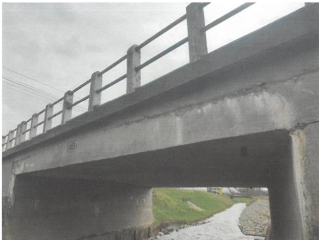
Fot. 17. Widok od strony dolnej wody n płytę pomostu – białe zacieki, zarysowania i ubytki materiału bocznej powierzchni betonu świadczące o korozji ługującej betonu.
