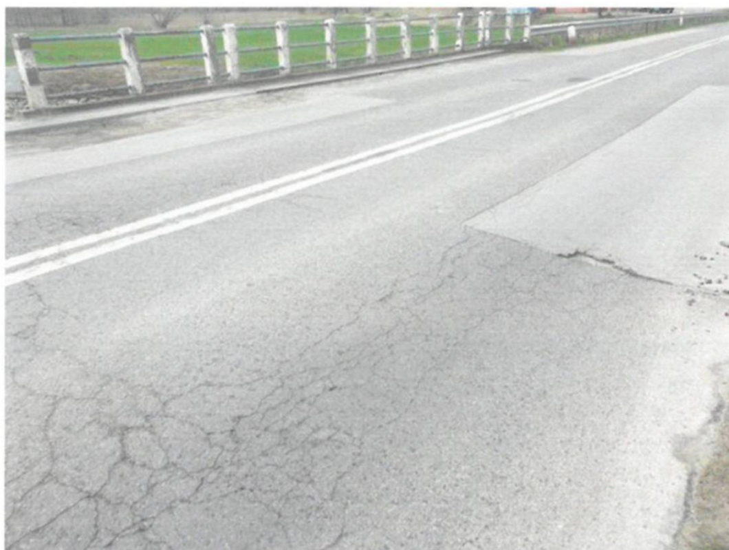
Fot. 41. Widok na dojazd od strony Sokołowa – siatka spękań i ubytki nawierzchni jezdni.
