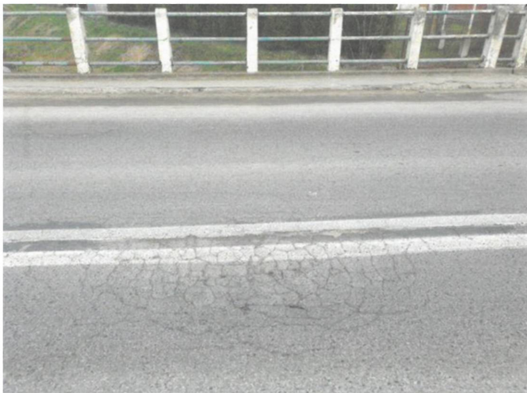
Fot. 6. Widok na nawierzchnię jezdni w przęśle – liczne spękania i deformacje nawierzchni jezdni.
