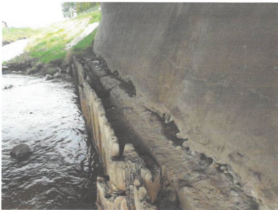
Fot. 35. Widok na przyczółek od strony Łańcuta – ubytki betonu w dolnej części korpusu powstałe w wyniku erozji wodnej.
