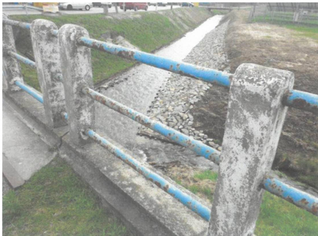
Fot. 12. Widok od strony Sokółowa na balustradę od strony górnej wody – liczne ślady korozji, ubytki powłoki malarskiej.
