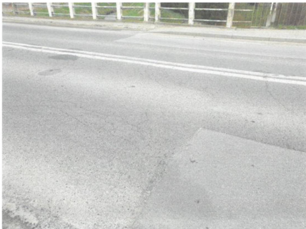
Fot. 16. Widok na nawierzchnię jezdni nad szczeliną dylatacyjną od strony Łańcuta – pęknięcia jezdni na szczelinę
