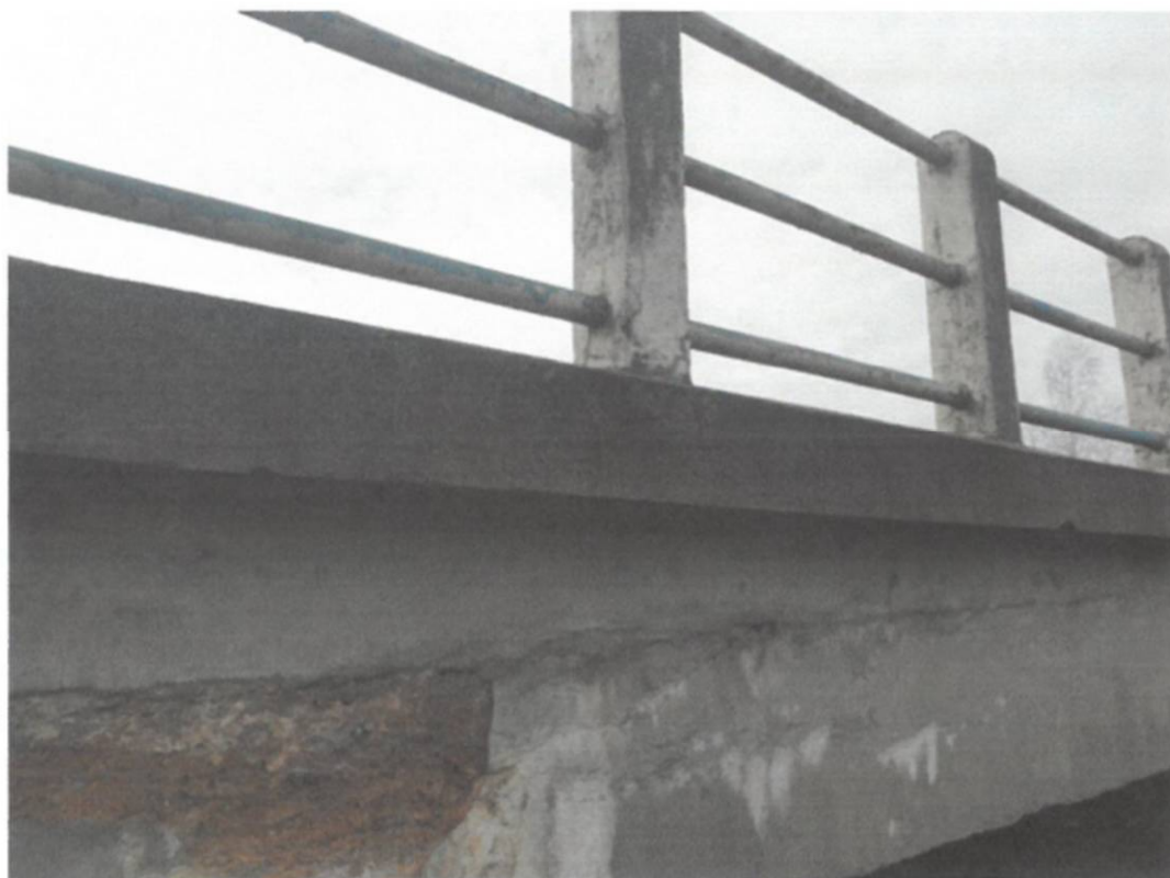
Fot. 11. Widok na gzyms od strony dolnej wody – ubytki betonu gzymsu.
