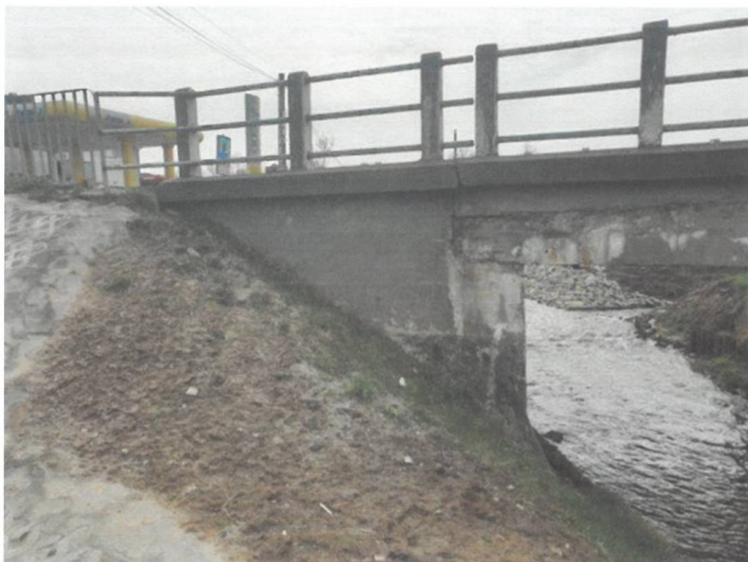
Fot. 37. Widok od strony dolnej wody na skrzydełko przyczółka od strony Łańcuta – zacieki powstałe z powodu braku przekrycia dylatacyjnego.
