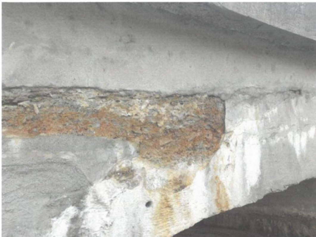
Fot. 25. Widok na boczną powierzchnię płyty pomostu przy przyczółku od strony Łańcuta od dolnej wody – białe zacieki, zarysowania i ubytki materiału bocznej powierzchni betonu świadczące o korozji ługującej betonu.
