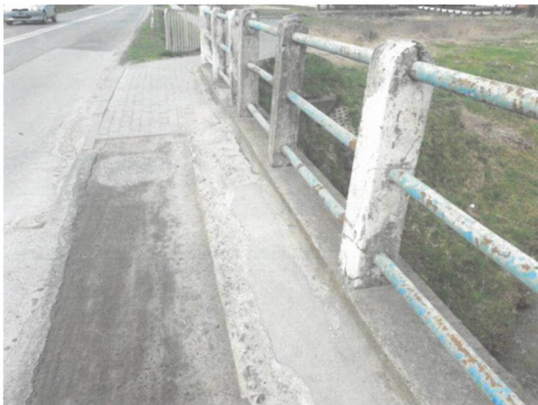
Fot. 13. Widok na balustradę od strony dolnej wody – liczne ślady korozji, ubytki powłoki malarskiej i ubytki betonu słupków.
