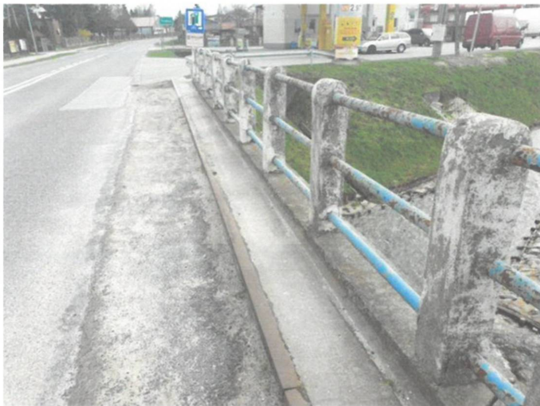
Fot. 7. Widok od strony Sokołowa na chodnik od strony górnej wody – korozja kątownika kapy chodnikowej, zanieczyszczenia na powierzchni pobocza.
