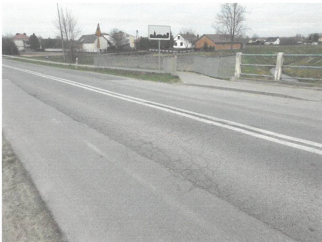
Fot. 5. Widok na nawierzchnię jezdni nad przyczółkiem od strony Sokołowa – siatka spękań nawierzchni jezdni.
