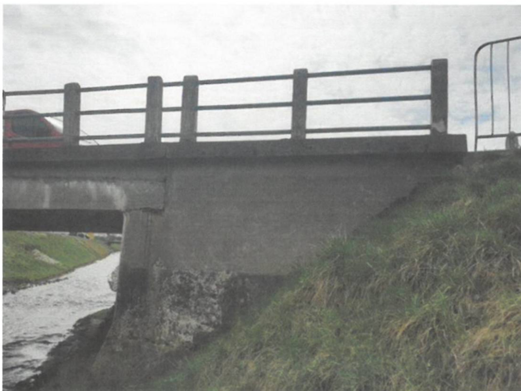
Fot. 28. Widok od strony dolnej wody na skrzydelko przyczółka od strony Sokołowa – zacieki powierzchni bocznej z papy pod płytą pomostu, ubytki betonu oraz niedostateczne obsypanie skrzydelka w górnej części.
