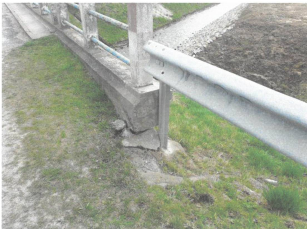
Fot. 42. Widok na dojsię do mostu od strony Sokołowa od górnej wody – niedostateczne obsypanie skrzydełka, porost trawy na powierzchni ścieku naskarpowego i schodów naskarpowych.
