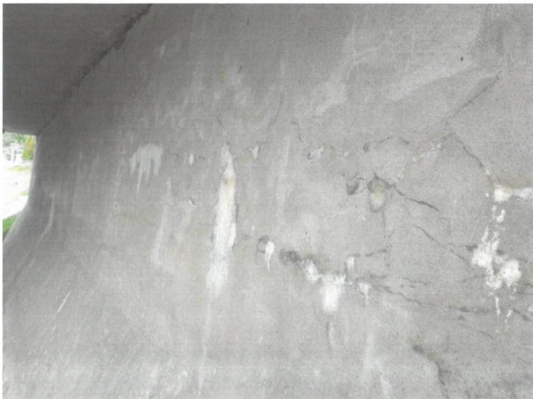
Fot. 34. Widok na przyczółek od strony Łańcuta – białe wykwity wapienne w miejscu poziomej rysy.
