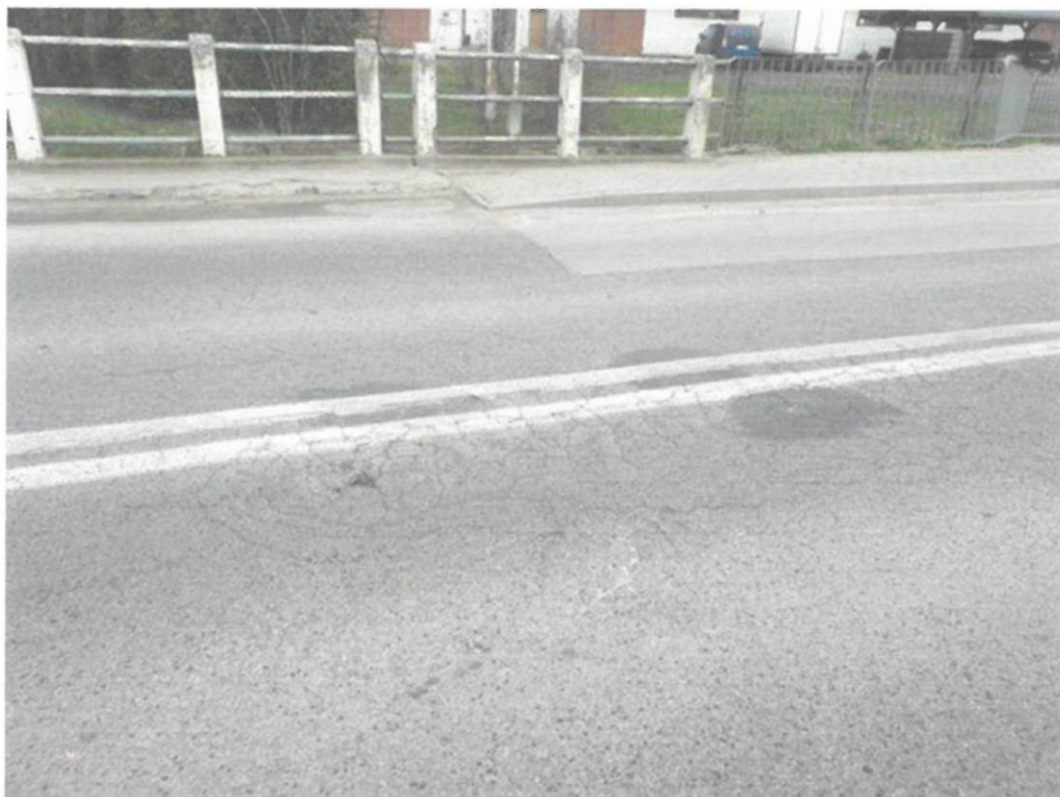
Fot. 39. Widok na dojazd od strony Łańcuta – siatka spękań w osi jezdni.
