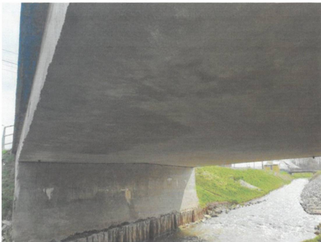
Fot. 27. Widok na płytę pomostu od strony dolnej wody – zawilgocenia powierzchni pomostu powstałe w wyniku uszkodzenia izolacji pomostu.
