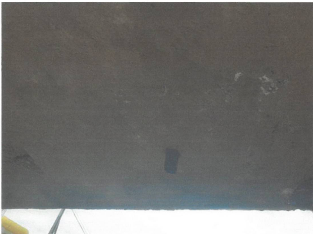
Fot. 20. Widok na dolną powierzchnię płyty pomostu w rejonie rury spustowej śączka – białe zacieki oraz ubytki betonu świadczące o przeciekach ze skorodowanej rwy.
