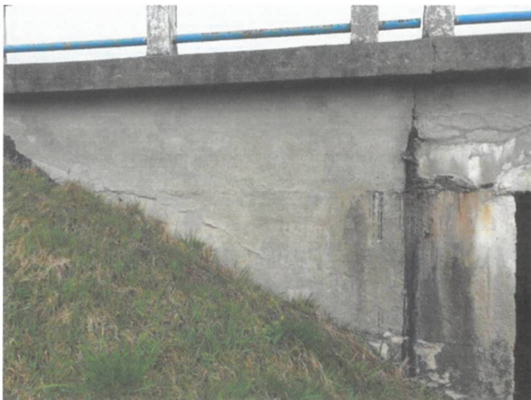
Fot. 29. Widok od strony górnej wody na skrzydelko przyczółka od strony Sokołowa – zacieki powierzchni bocznej z papy pod płytą pomostu oraz zacieki powstałe z powodu braku przekrycia dylatacyjnego, zarysowania, niedostateczne obsypanie skrzydelka w górnej części.
