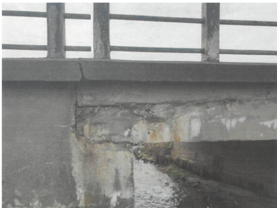
Fot. 24. Widok na boczną powierzchnię płyty pomostu przy przyczółku od strony Łańcuta od dolnej wody – białe zacieki, zarysowania i ubytki materiału bocznej powierzchni betonu świadczące o korozji ługującej betonu.
